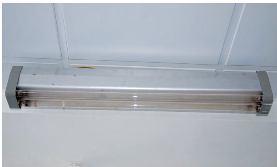
РИС. 13 Бактерицидная лампа для проведения трехразового кварцевания в рабочем кабинете
